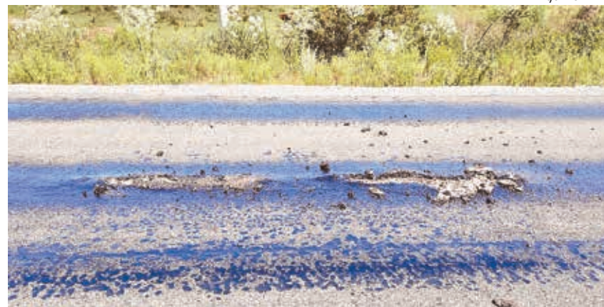
Rodovia apresentou problemas na camada asfáltica
