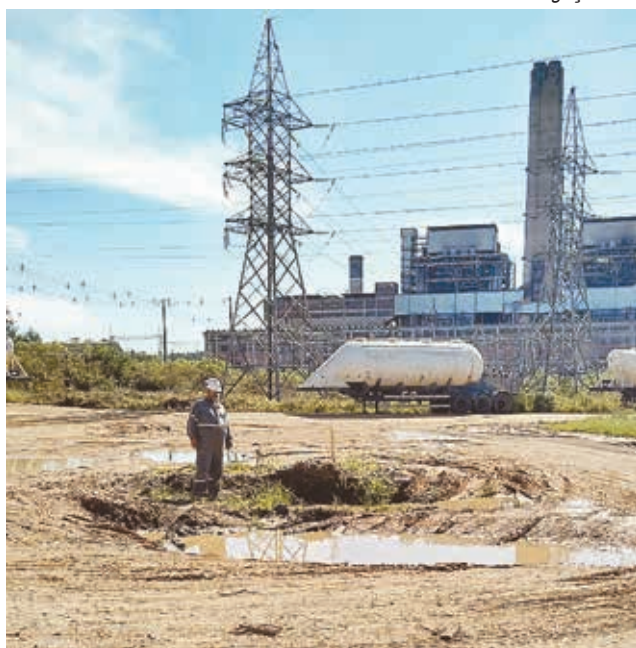
Imagem mostra um atoleiro no estacionamento
