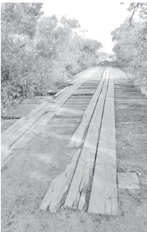
Ponte foi interditada em fevereiro deste ano
