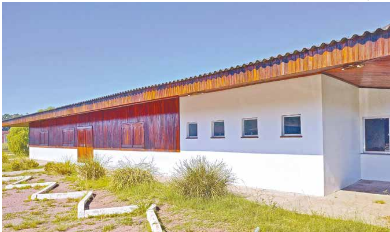
O prédio já recebeu pintura interna e externa
