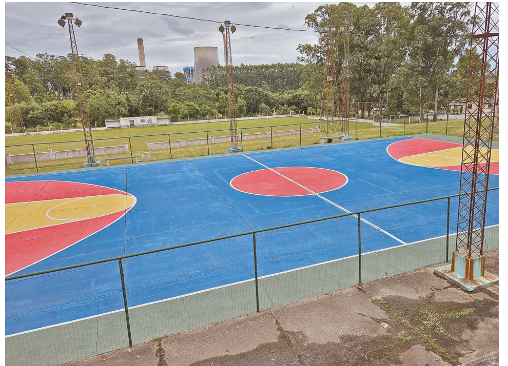
Quadra já recebeu pintura e cercamento
