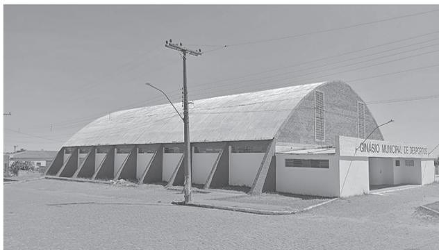
O telhado do ginásio municipal de Pinheiro Machado recebeu a primeira camada de impermeabilização com borracha líquida. Segundo o Executivo, as melhorias consistem também na troca de 12 telhas danificadas, visando garantir a segurança e o conforto
