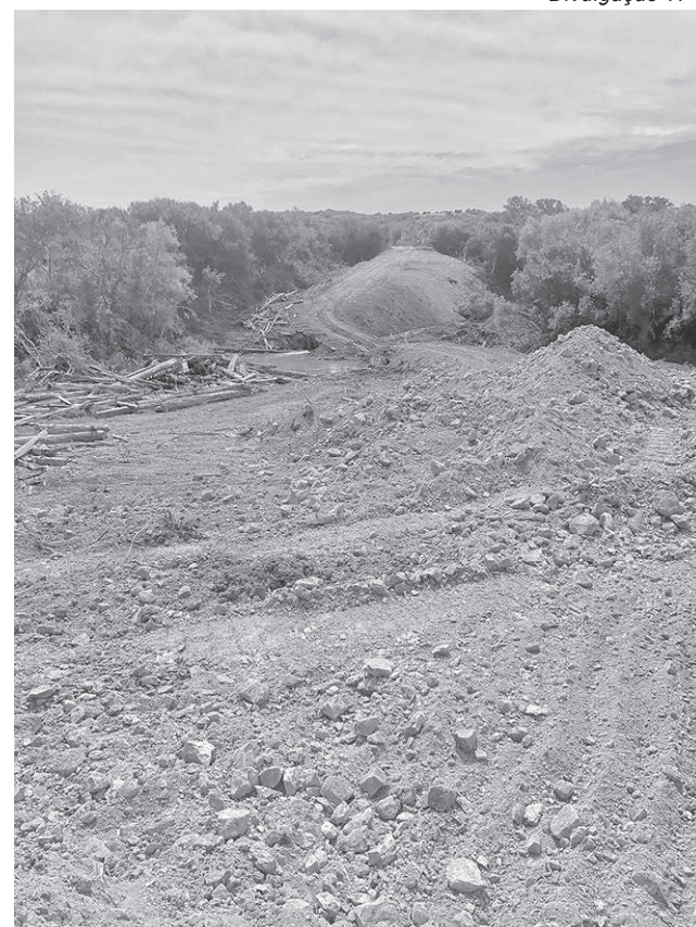
Tráfego no local está ocorrendo por meio de um desvio e obra da nova ponte deve começar em breve
