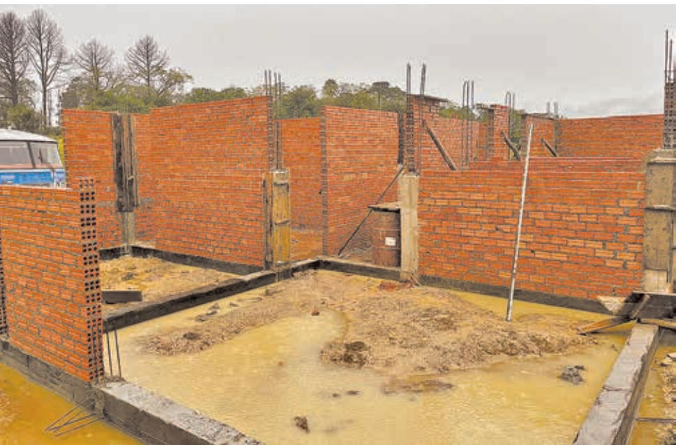
Ampliação da UBS é aos fundos do Cais
