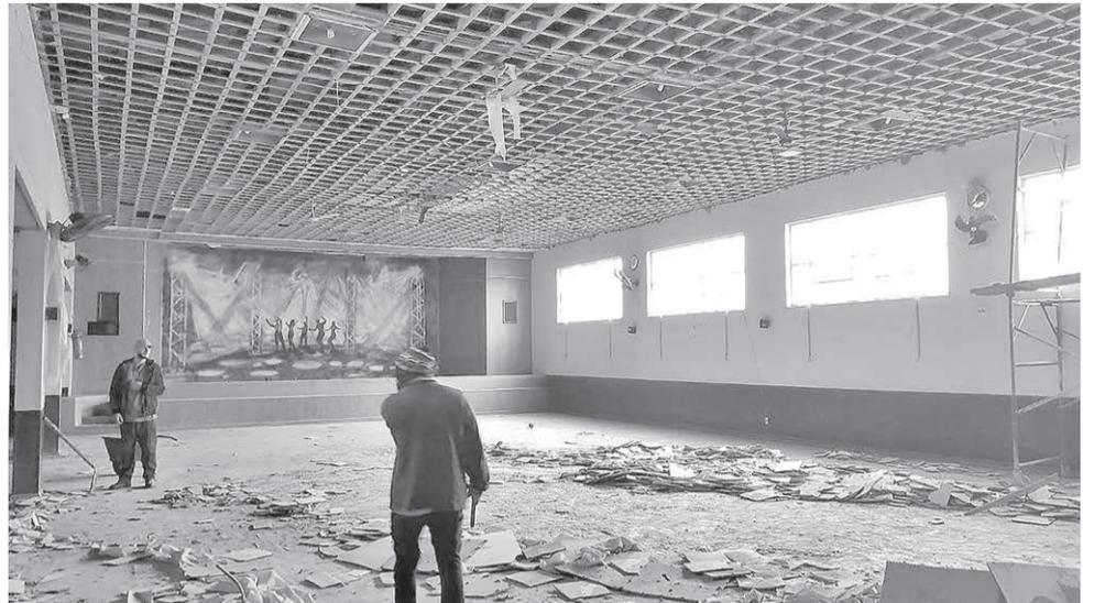
Neste momento o forro está sendo retirado para avaliar o comprometimento da estrutura do telhado
