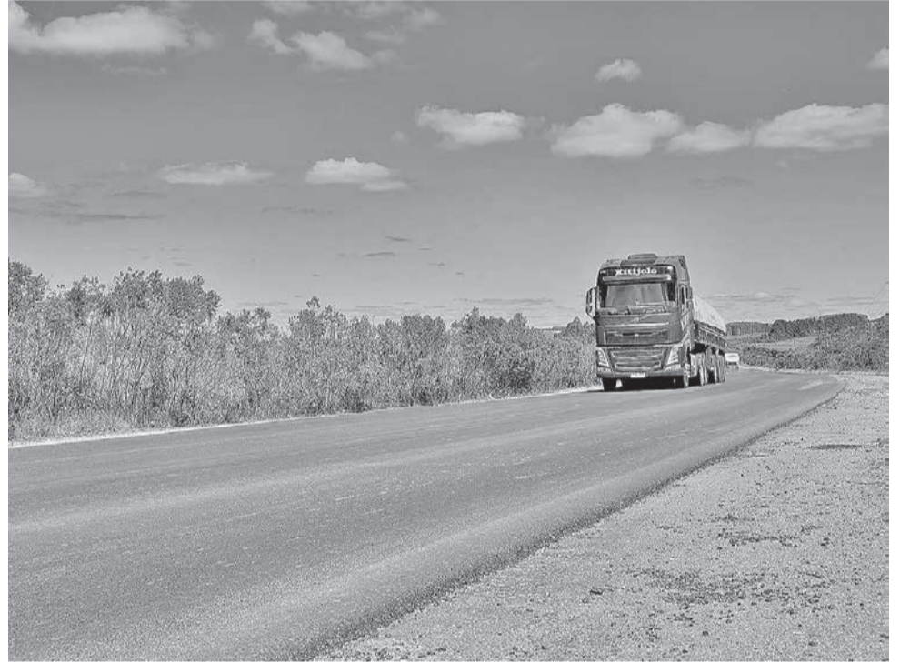
Diversos trechos passaram por fresagem ao longo da MAC
