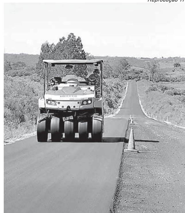
Maquinários estão trabalhando no local
