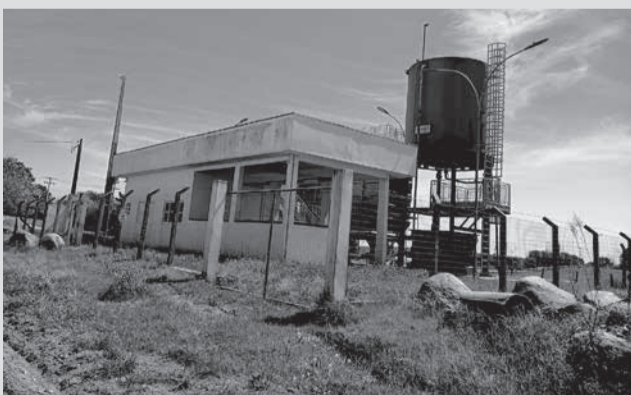
A exemplo da ETA constuída na Trigolândia, município pretende construir nova estação no interior
