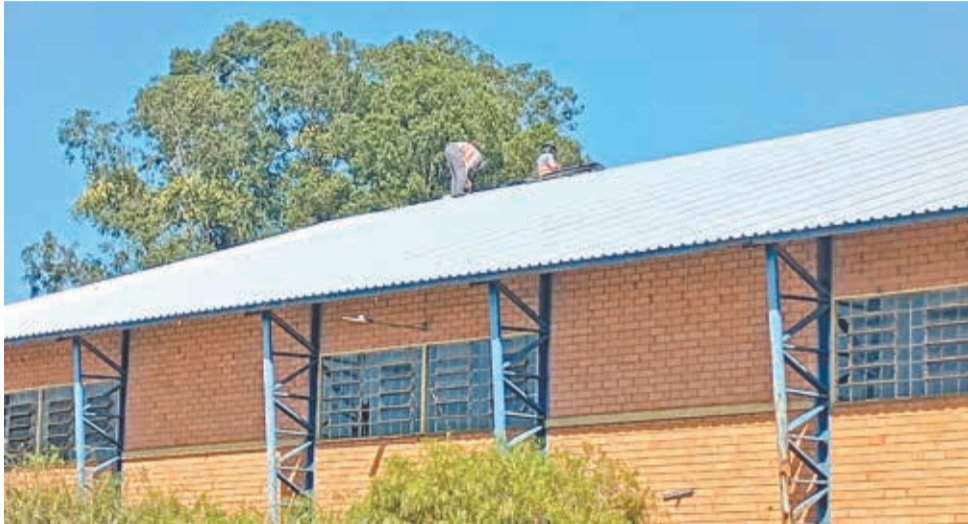
Trabalhos iniciaram pela troca do telhado que já apresenta grande avanço
