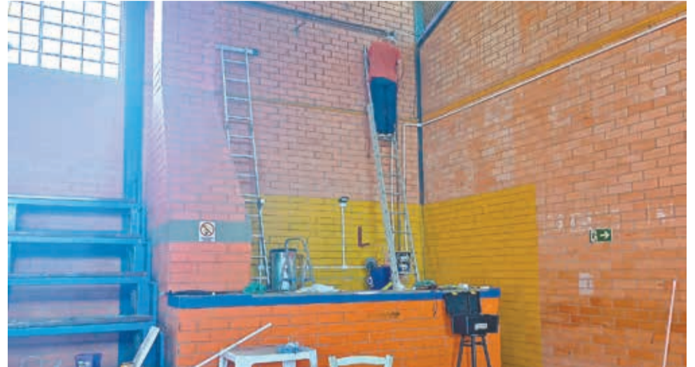
Rede elétrica também já está sendo revitalizada
