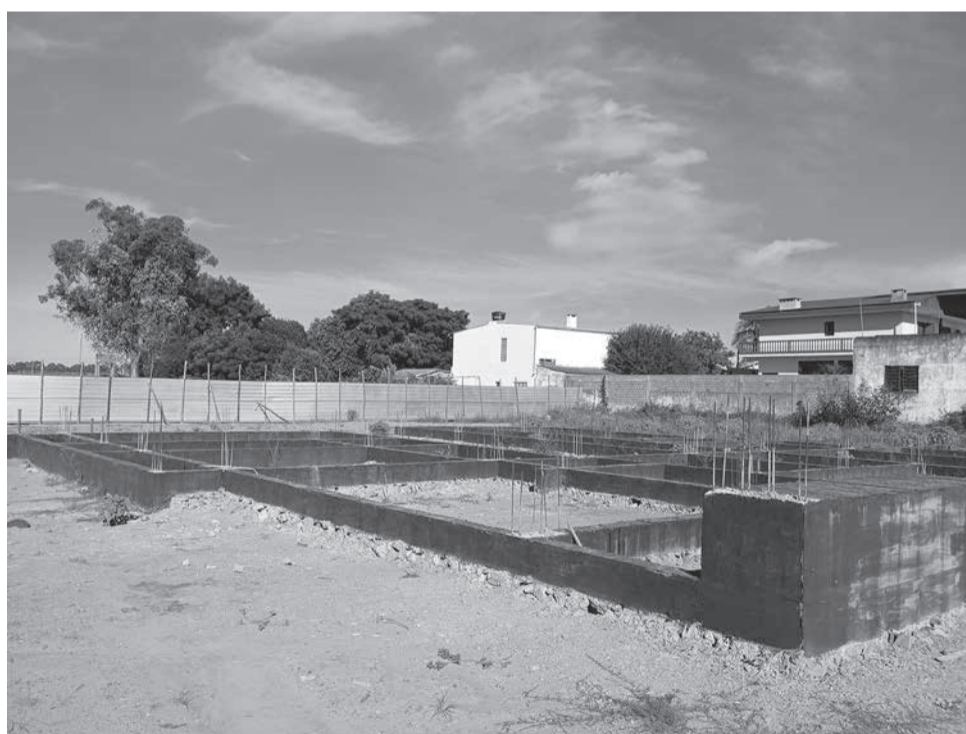
Obra está com a base (fundação) realizada
