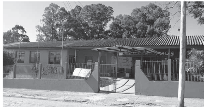
Prédio foi interditado em junho de 2025
